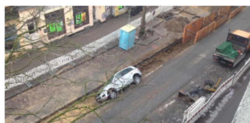
03.02.2014 STERNESCHANZE Verfahren? Auto landet in Baugruben
